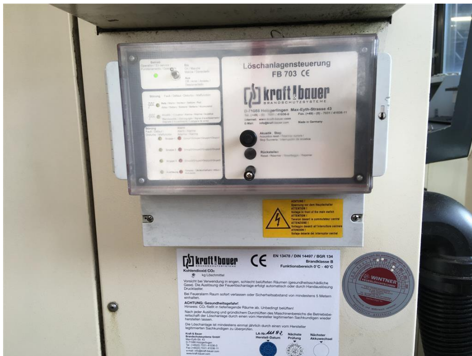
Feuerlöschanlage
